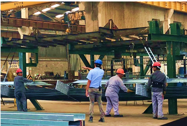
Figura 2. Proceso de colgado de varilla.
