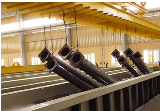
Figura 4. Decapado de materiales. Fuente: www://frpstoragetanks.in/pickling-plant/
